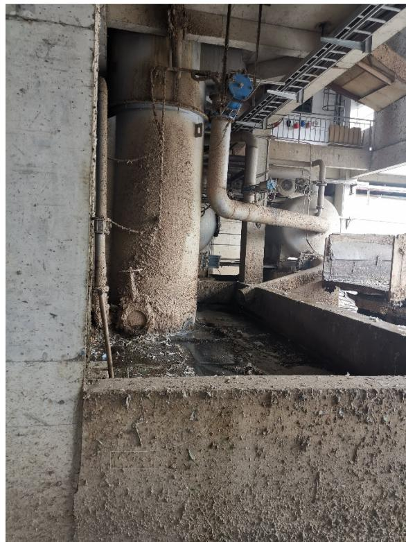
本公司在碎浆车间打浆系统渣浆收集池加高进行围挡，避免废水撒漏。
