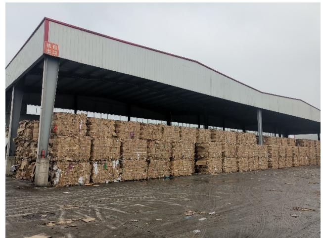
废纸堆场会在雨天，因雨水的冲刷，产生的地表径流可能会渗入地下，对地下水水质产生一定的污染。目前，项目在部分废纸堆场设置雨棚，在降雨期间对露天废纸堆场进行防雨篷布遮盖，地面做了硬化、防腐处理，同时在废纸堆场周围设置导流沟。
