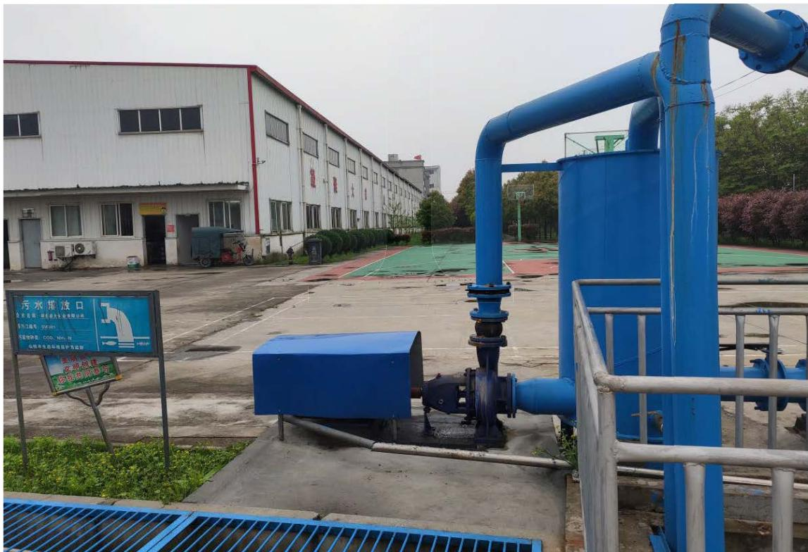
梳理全场雨污管线走向，完善雨污管网分流图；污水总排口加装提升泵，便于厂区污水泵入张沟镇污水处理厂。
